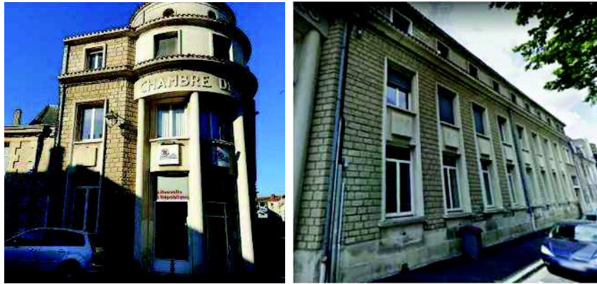
Parties courantes des façades
