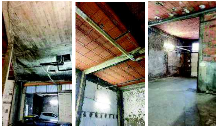
Planchers et ossature poteaux / poutres béton visible dans le garage
