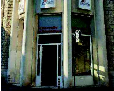
Ensemble vitré du RDC
