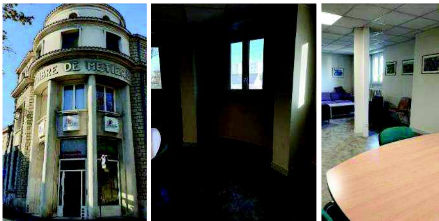
Poteaux côté entrée, visibles depuis l'extérieur et au R+2
