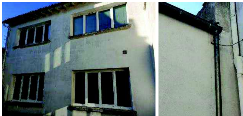
Façades du patio
