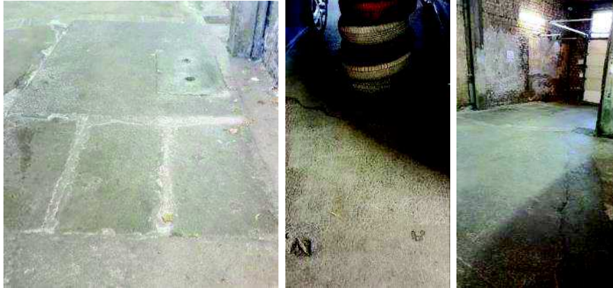
Dallage béton du garage
