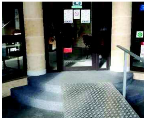
Marches du sas d'entrée
