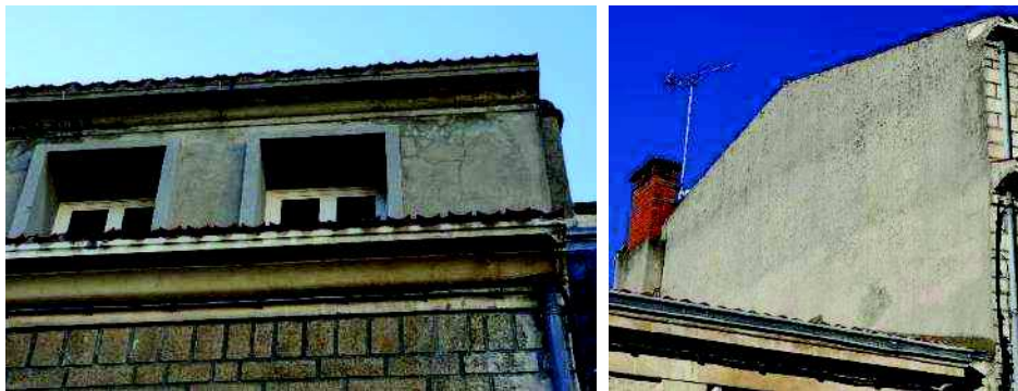
Façades enduites, côté rue
