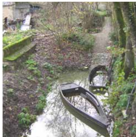
Petits ports en friche, cales dégradées, bras d'eau comblés...
