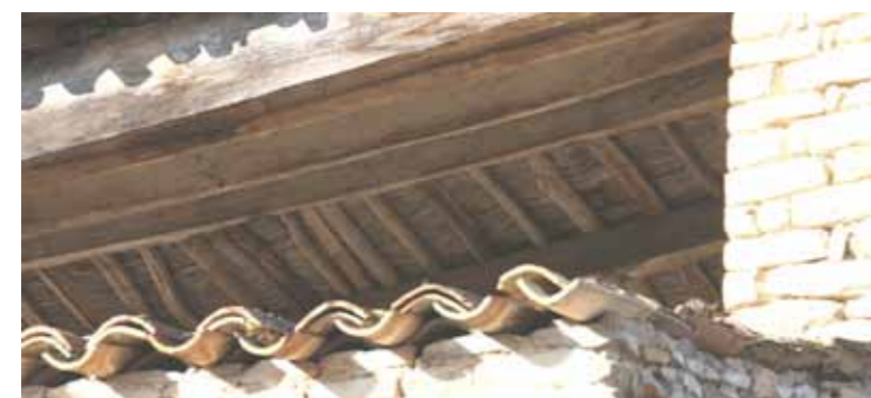
Roseau en support de tuiles
