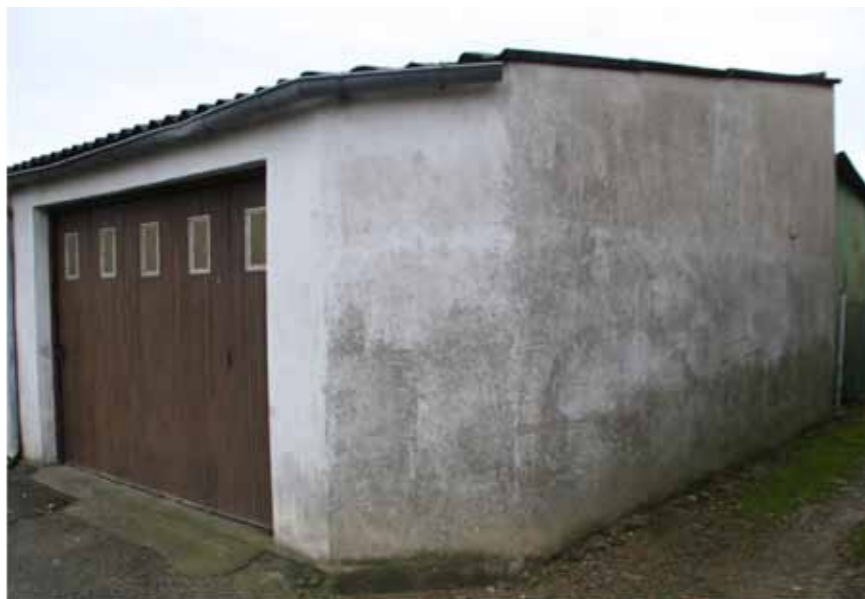
garages et hangars
