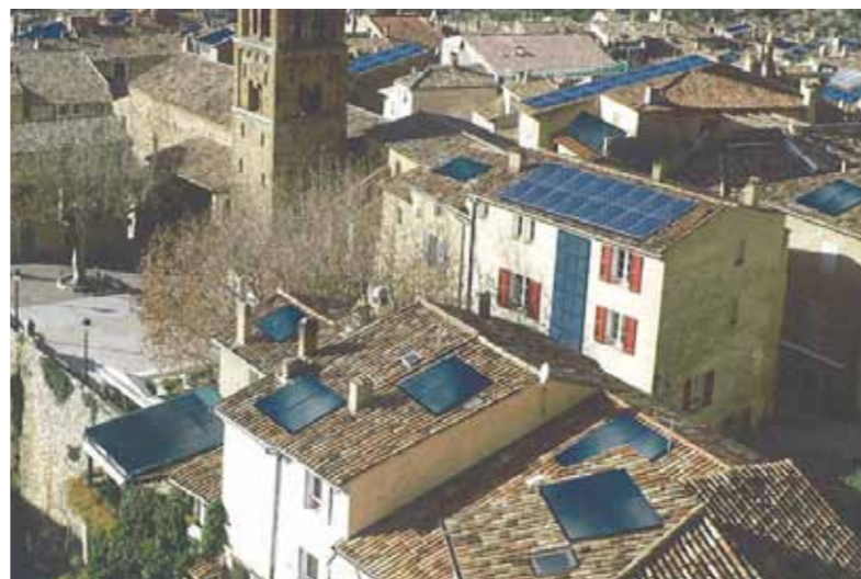
Solution tragique des panneaux solaires
