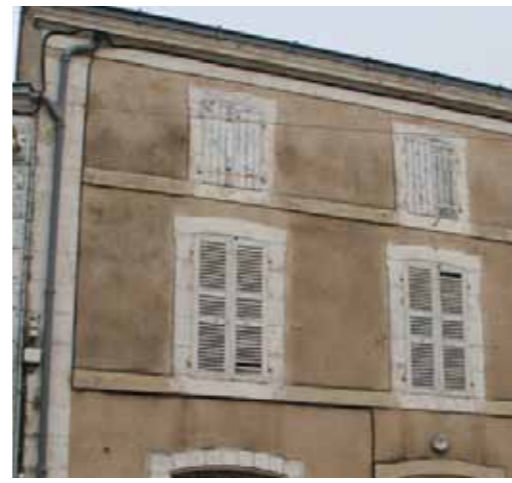
Moellons enduits sur maison d'habitation
