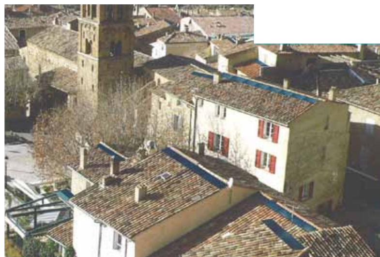
Solution acceptable en bandeaux des panneaux solaires
