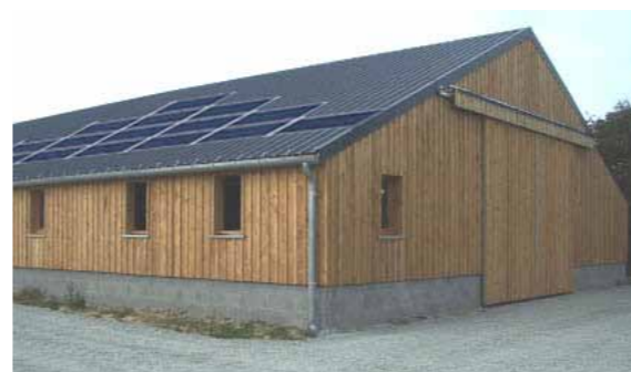
Image 3 : implantation de capteurs de manière morcelée
