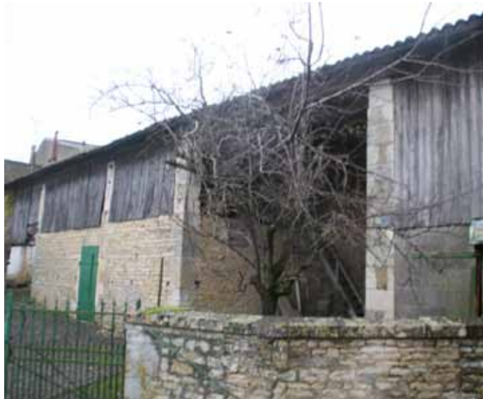
Bâtiment agricole de qualité en bon état
